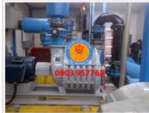
Sửa chữa máy thổi khí
